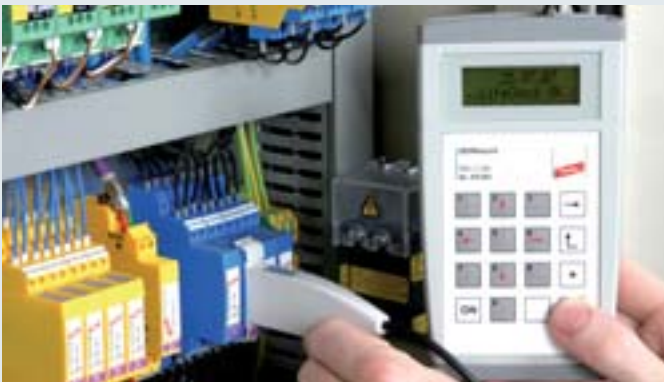
Test d'un module DPS à l'aide de la technologie RFID
