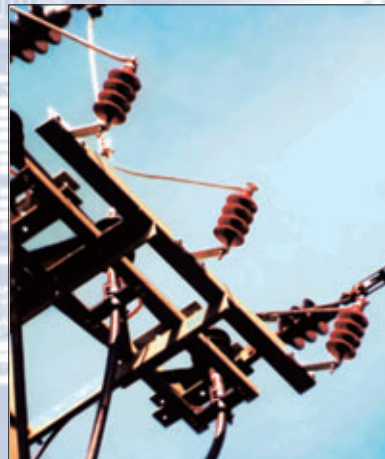
Et maintenant protection contre les surtensions des installations du réseau HTA.
