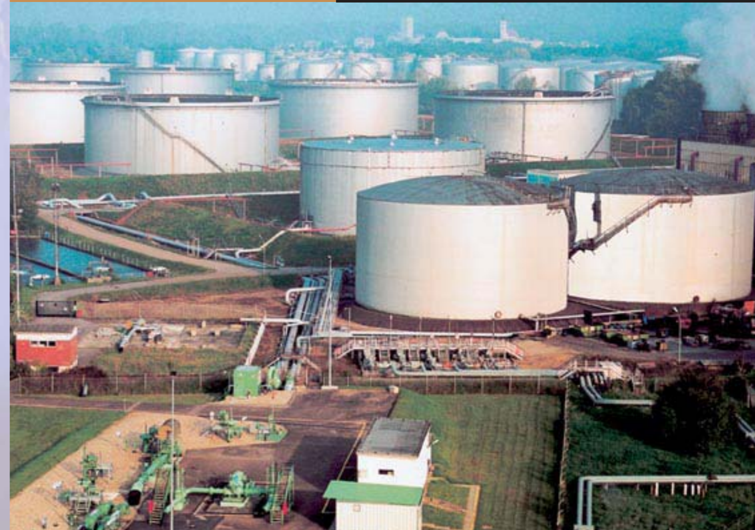
Prinzipdarstellung: Feldgeräte (Transmitter, . . .) an Pipeline oder Lagertank mit brennbarer Flüssigkeit. Schematic diagram: Process field devices (transmitters. . .) at pipeline or vat with flammable liquid.
